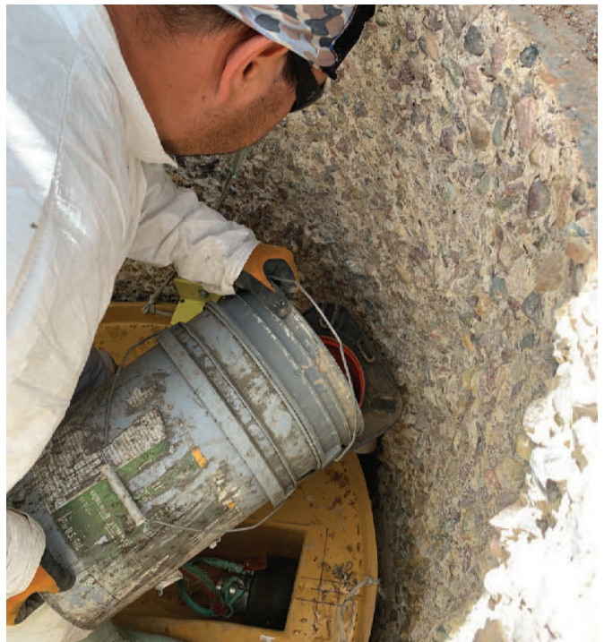
Pour high-flow, non-shrink grout behind liner
